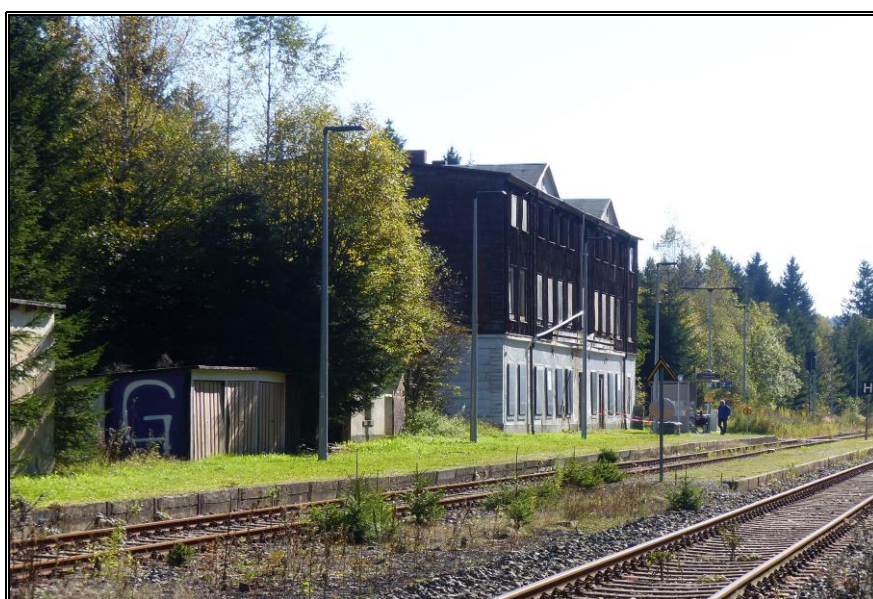
Současný stav budovy dopravní Zwotental (10. 10. 2021)
